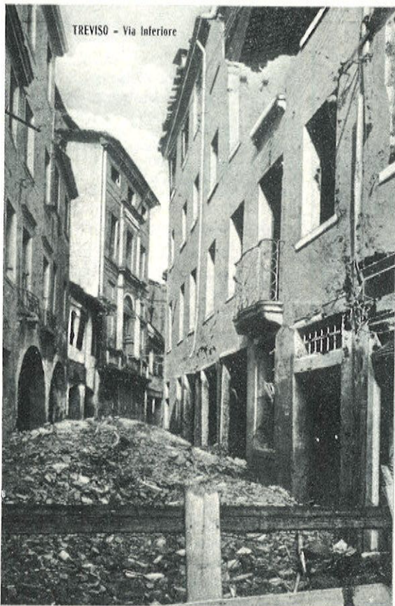
Via Inferiore, dove c'è la nostra sede chiusa dalle macerie.
